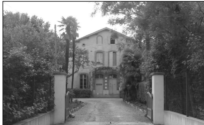
Het vakantiecentrum in Béthanie
